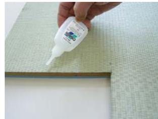
③畳表のほつれ止めのため畳表の裁断面に瞬間接着剤を施します。
