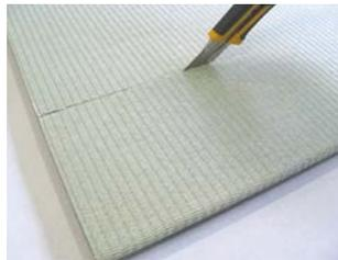
①浴室の形状に合わせてカッター等により畳を裁断します。なるべく裁断面が壁側、浴槽壁面になるようにしてください。
